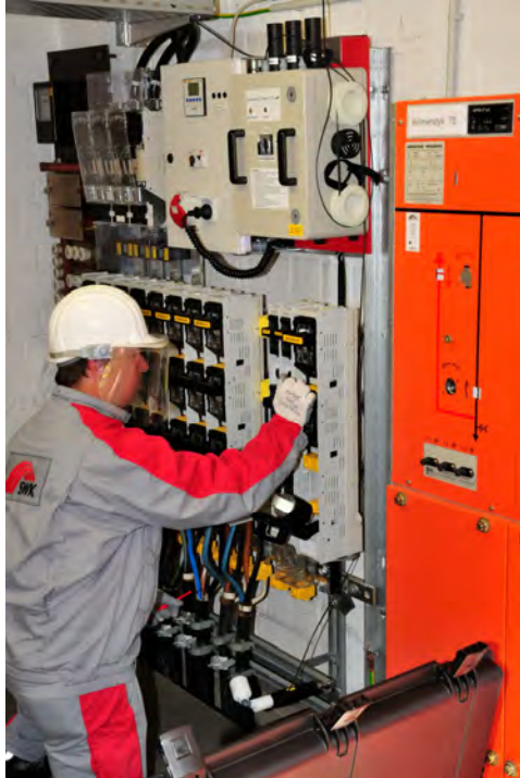
Bild 2.10: Einsetzen der Kurzschließerpatronen DEHNarc KSP und des Trennmessers DEHNarc TRM
