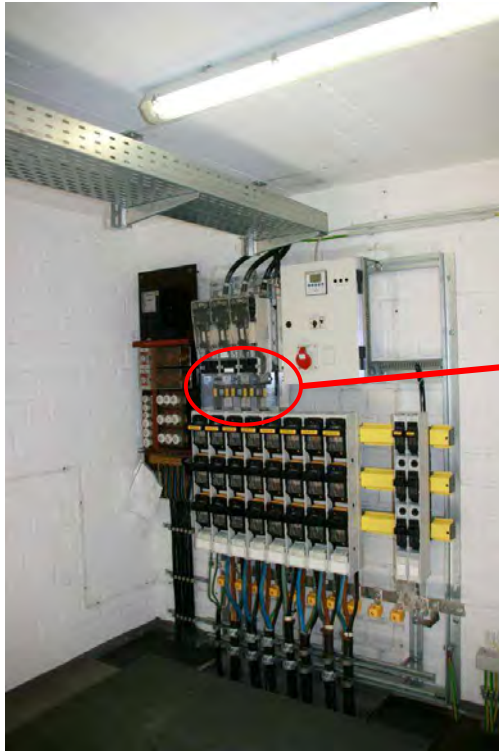
Bild 2.2: Sammelschienen
