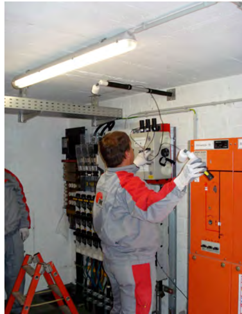
Bild 2.11: Montage der Sensoren
