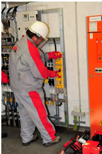
Bild 2.4: Einbau einer verriegelbaren NH-Sicherungsschaltleiste
