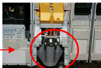
Bild 2.9: DEHNarc KST an Kabelanschlüssen der NH-Sicherungsschaltleiste montiert
