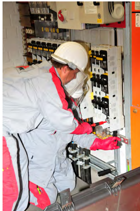
Bild 2.7: Montage Knotenstück DEHNarc KST
