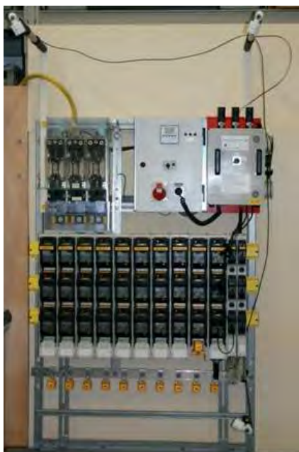
Bild 2.12: DEHNarc montiert
